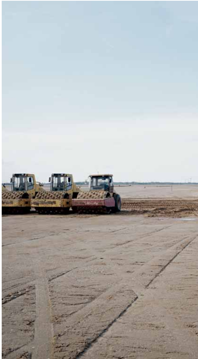
Der neue Standort: 208 Hektar Grund, nördlich von Leipzig. Im Spätsommer 2001 wird das Gelände für den Bau vorbereitet. Fast vier Millionen Kubikmeter Erdbreich werden bewegt, um das Nord-Süd-Gefälle auf dem Grundstück auszugleichen – ein Volumen, das der Ladung von rund 100.000 LKW entspricht.
