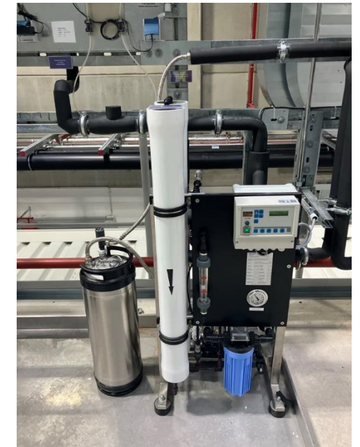
Bild: Umkehr-Osmose-Anlage Hochvoltbatteriefertigung
