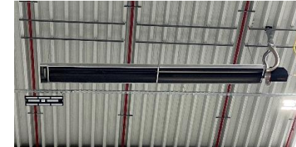
Bild: Dunkelstrahler in der Hochvoltbatteriefertigung
